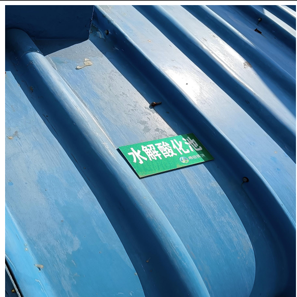
污水处理站（水解酸化池）
