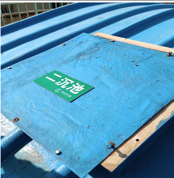
污水处理站（二沉池）
