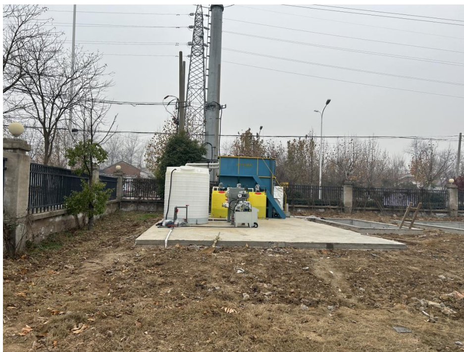
图 4.1-2 污水处理站现状图
