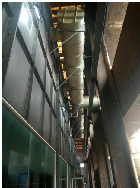
图 6.2-2 酸雾收集方案（整体密闭式）
