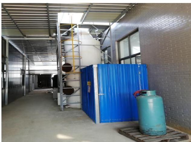
图 3.8-3 水喷淋塔装置
