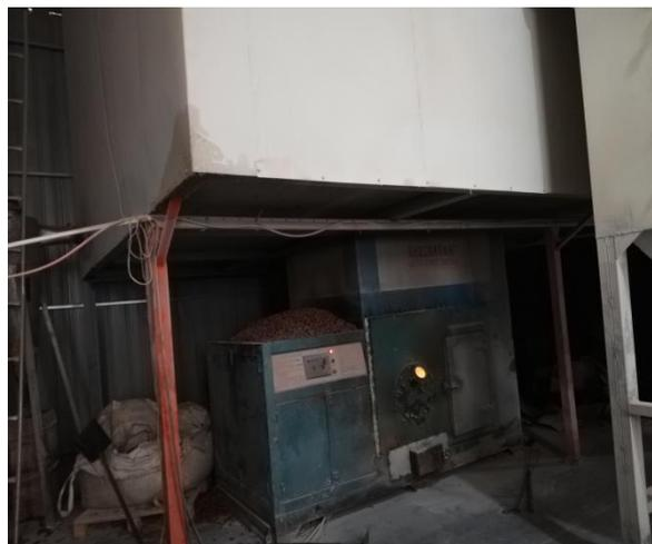
生物质颗粒燃料及热风炉装置
